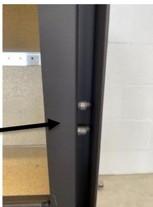
Deux fois par an, nettoyez la charnière de la porte, enduisez-la d'une huile dégrippante afin d'empêcher l'humidité de pénétrer et de bloquer l'axe de celle-ci.
