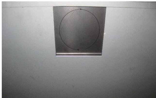
Si l'appareil est muni d'un thermostat automatique et que l'on fait un raccordement d'air de combustion à l'extérieur, il est conseillé de placer un registre à câble entre l'appareil et la grille extérieure. Ce registre servira à condamner l'arrivée d'air lorsqu'on ne se sert pas du foyer.
