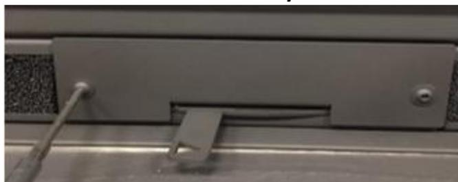
On raccorde la prise d'air extérieur, soit par l'arrière via le buselot, soit par le dessous (faire sauter l'opercule et boucher l'entrée arrière). Dans ce cas, on conserve la face avant de la boîte à air. Prévoir une pente vers l'extérieur pour évacuer la condensation.
